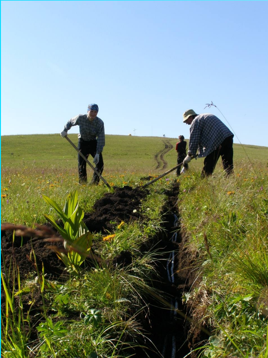
Прокладка кабеля длиной 800 м в июле 2008
