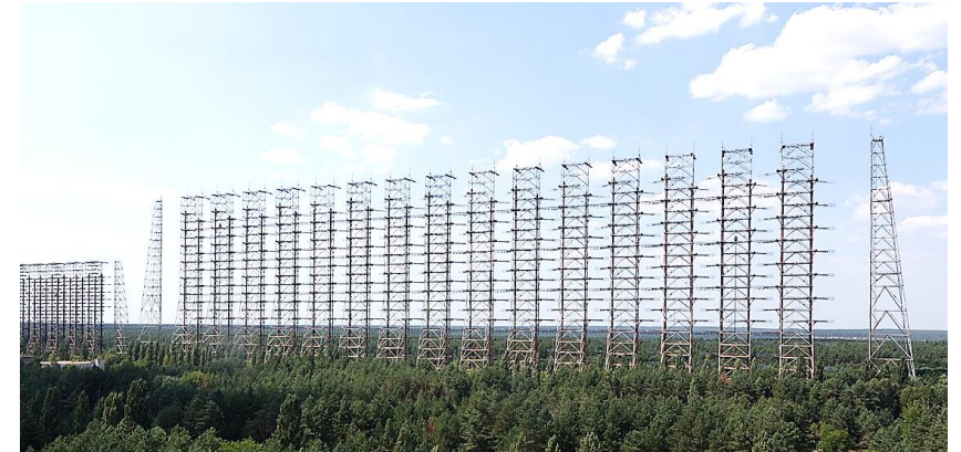
«Дуга» (5Н32, Чернобыль-2) — советская загоризонтная радиолокационная станция. Большая антенна \sim 150 м в высоту.
