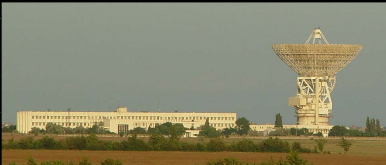
70-метровая евпаторийская антенна. О размерах этого уникального сооружения можно судить по узенькой светлой полоске бетонного забора высотой 3 м, что на переднем плане фотографии. Фото А. Л. Зайцева
